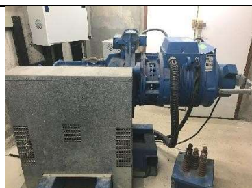
Machinerie ascenseur de service bâtiment C
